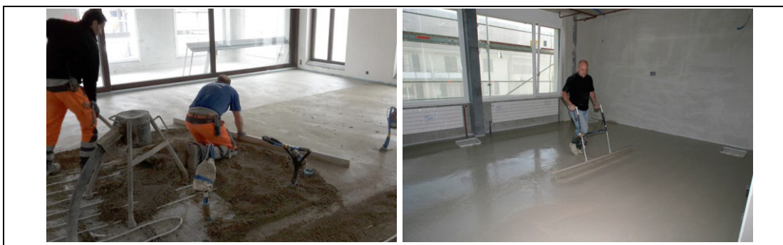
Abbildung 1: Anhydrit-UB. links: Einbau konventionell, rechts: Einbau Fließbelag (Bilder: KBS)
