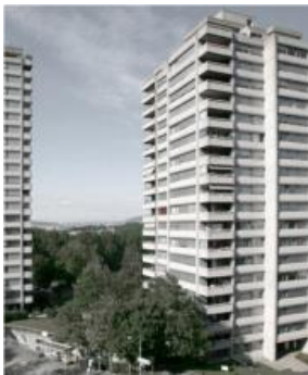
Abb. A. 24 Bild vor Umbau
