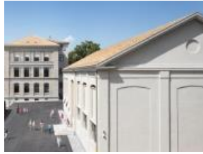
Abb. A. 3 sanierte Schulanlage B und C
