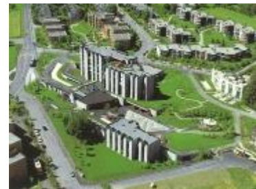
Abb. A. 15 Altersheim B vor Sanierung
