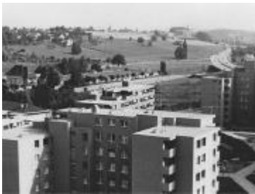
Abb. A. 19 Siedlung B vor Sanierung
