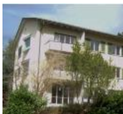
Abb. A. 21 Bild vor Umbau
